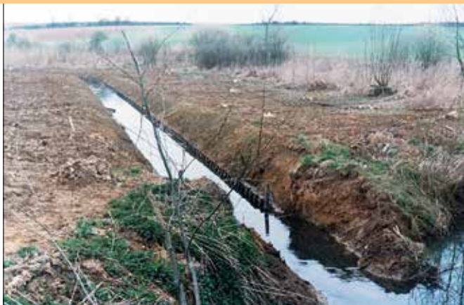
■ De Schoorbroekbeek werd door de provincie in 1993 uitgediept, rechtgetrokken en ingekapseld in een oeverversteving van hardhout. Foto Jaak Geebelen
