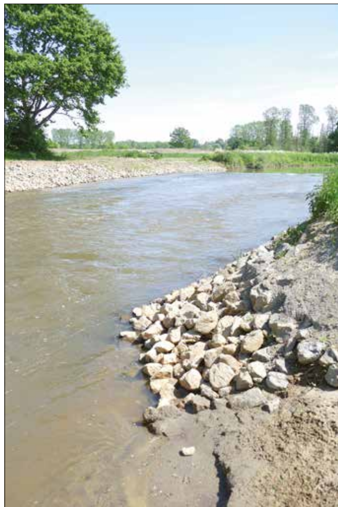
■ Onderwaterdrempel met keien stuwt bij laagwater Demerpeil terug hoger, hier ter hoogte van de Kloosterbeemden Zichem. Foto Luc Vervoort
